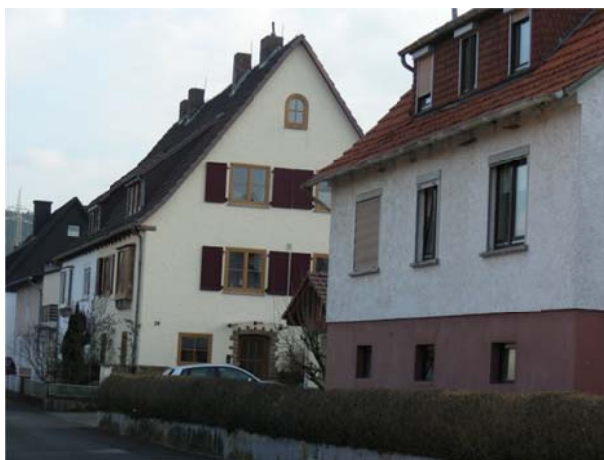
Abbildung 44: Siedlung im Heimatstil, Baumbach
