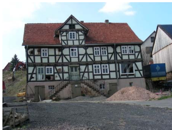
Abbildung 23: Typischer Fachwerkbau, Oberellenbach
