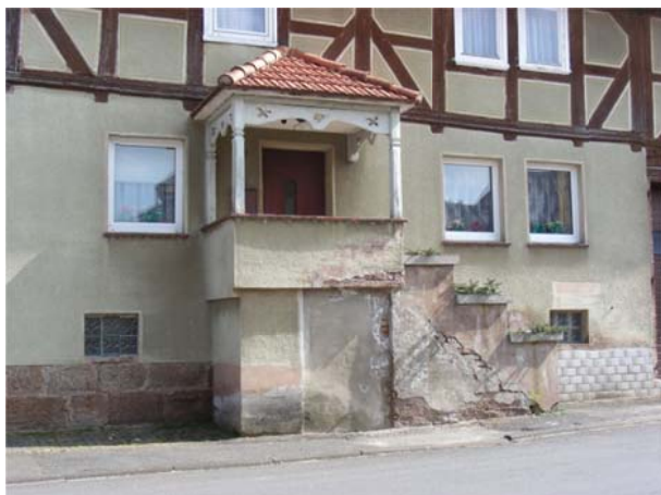
Abbildung 51: Typische Außentreppe mit Überdachung des Podestes, Sterkelshausen
