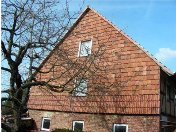
Abbildung 49: Typischer Wandbehang mit Ziegeln, Niederellenbach
