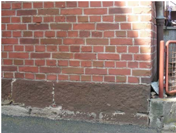
Abbildung 47: Sockel aus Buntstein, Erdgeschoss in Backstein, Sterkelshausen
