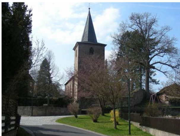
Abbildung 54: Freianlage mit Bepflanzung und Mauern um die Kirche, Oberellenbach
