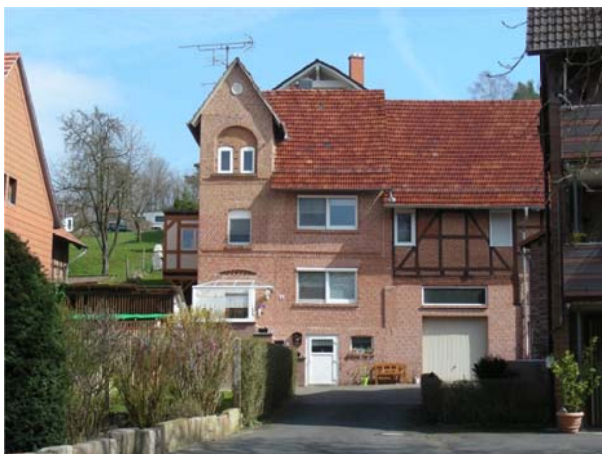
Abbildung 48: Sichtmauerwerk in Kombination mit Sichtfachwerk aus der Gründerzeit, Sterkelshausen
