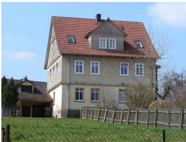
Abbildung 50: Typischer Wetterschutz aus Holzschindeln in den oberen Geschossen, Sterkelshausen
